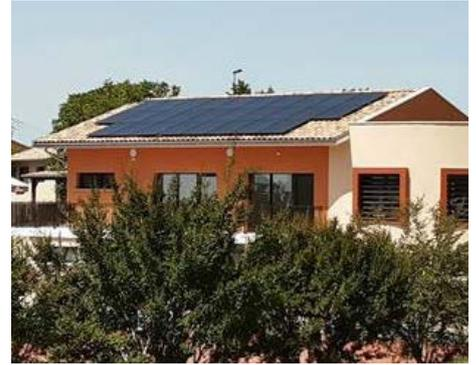
Le champ ainsi constitué présente un potentiel de production d'électricité instantané de 12Kwc (kilowatt crête) ; cette puissance théorique varie constamment en fonction de l'orientation et de l'intensité des rayons lumineux reçus par les panneaux. Les panneaux sont garantis 30 ans avec une baisse maximale de rendement de 15 % à l'issue des 30 ans. L'installation est ainsi conçue pour durer 30 ans et plus.
